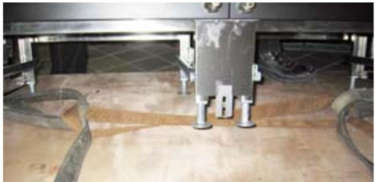
6. Nel caso di un trasporto in scale, le cinghie dei trasportatori situati in basso dovranno essere molto più corte per fare in modo che la cucina sia orizzontale. La parte posteriore della cucina sarà sempre situata sul lato interno della rampa.
